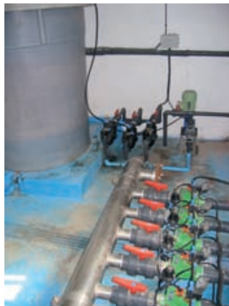
El mantenimiento del cabezal pasa, entre otras cosas, por controlar las presiones y vigilar los tanques fertilizantes y la bomba de inyección.
